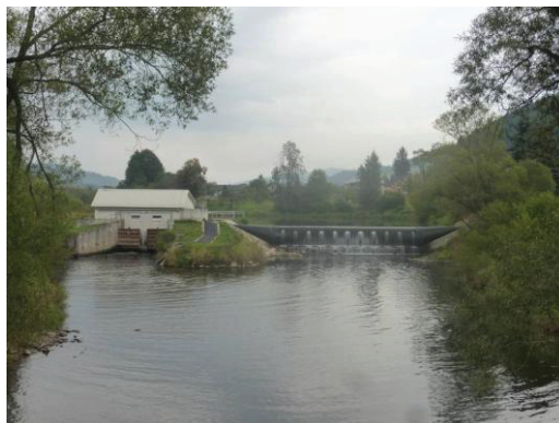
Obr. 4.11 Malá vodní elektrárna Beňuš – Filipovo (okres Brezno)
